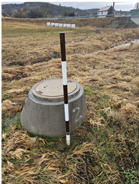
Kanalizace Kapsova Lhota 2023
