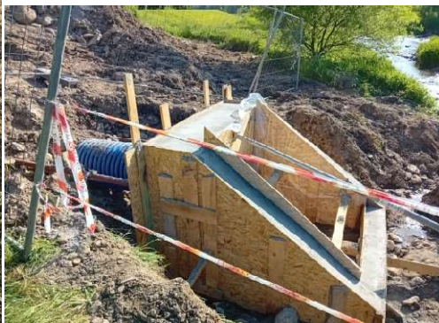
Odlehčovací potrubí Radošovice 2023
