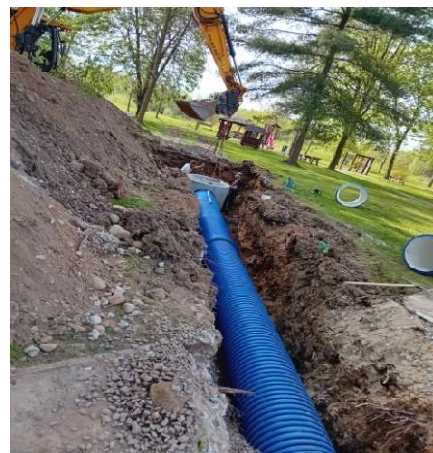
Odlehčovací potrubí Radošovice 2023
