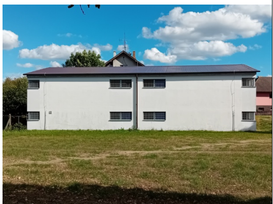
Střecha skladu čp.172 Radošovice 2026
