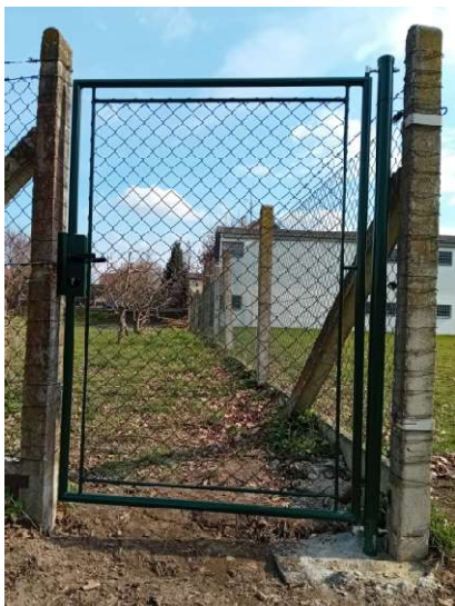
Oplocení skladu Radošovice 2026
