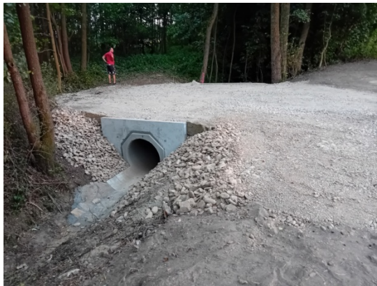
Propustek příjezd Kopaniny 2026
